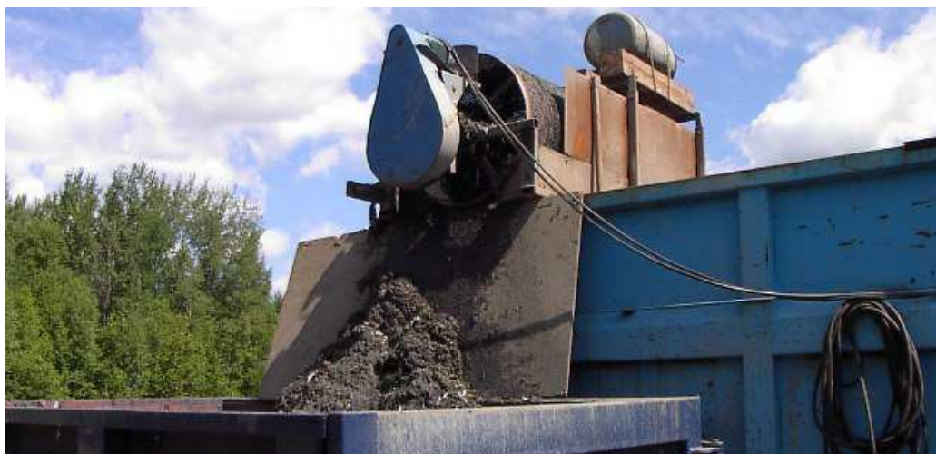
Figure 18. Centrifugeuse électrique pour la déshydratation des boues
