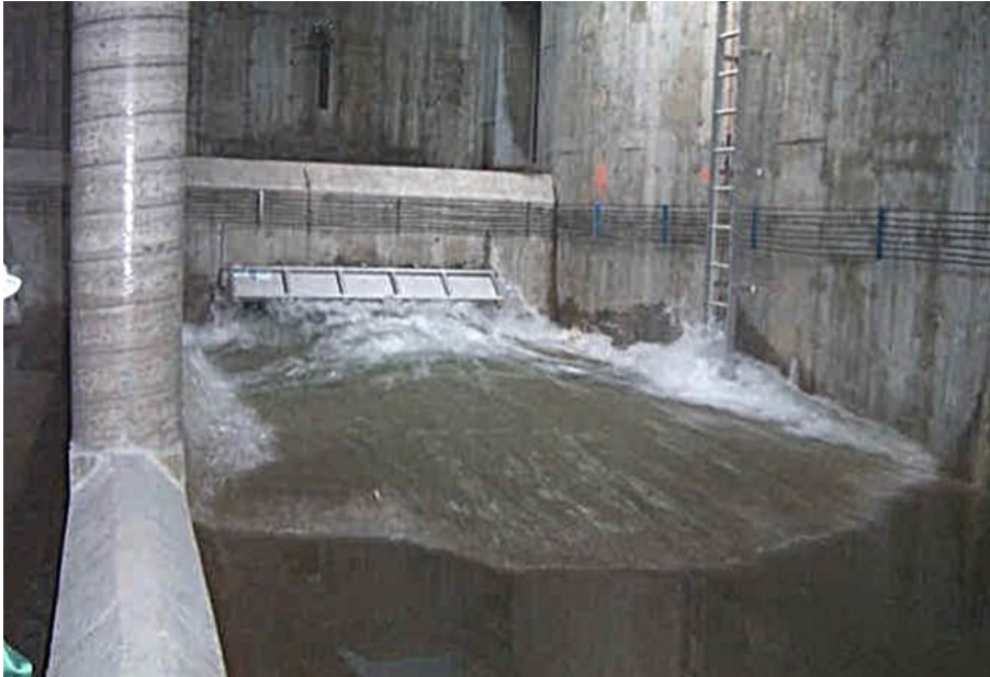
FIGURE 4.4 – Photo de déclenchement d’une porte de cellule de nettoyage.
