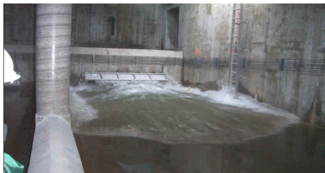
Figure 13: Photographie durant le nettoyage du bassin
