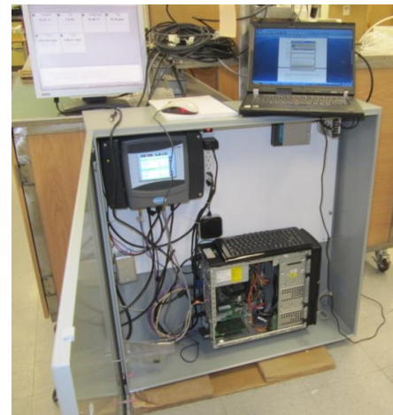
Figure 16 : Panneau de contrôle d'une station monEAU
