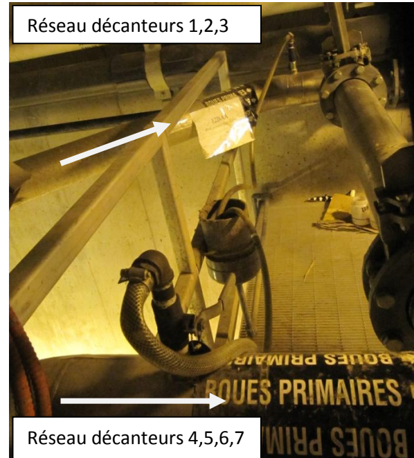
Figure A-3 : Conduites de boues primaires
