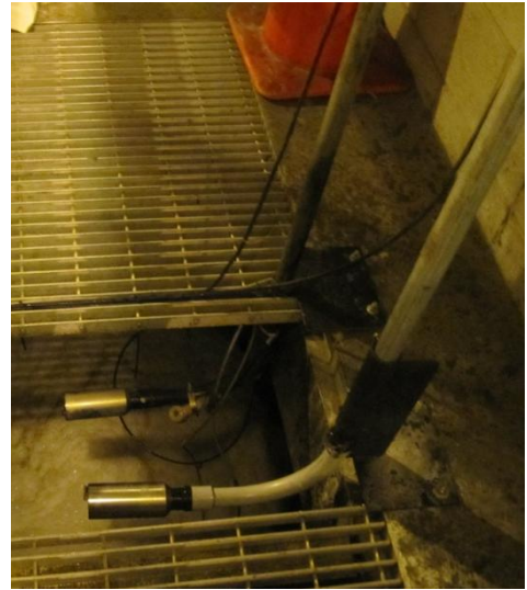
Figure 19 : Installation des deux sondes de turbidité à l'entrée des décanteurs primaires
