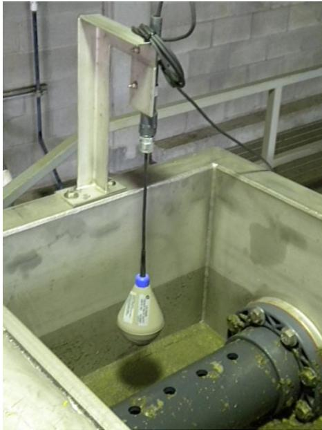
**Figure 66 : Flotteur du pilote primEAU**
