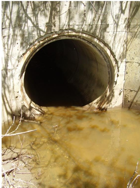
Figure 50 : Point d'installation amont des capteurs mesurant la hauteur et la vitesse
