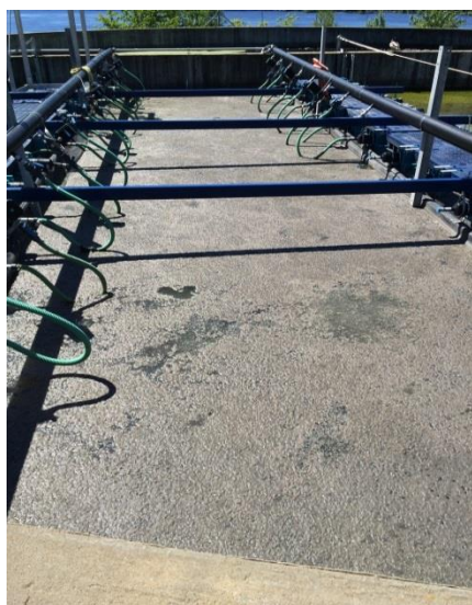
Figure 43 Remise en suspension de la matière dans les zones de décantation
