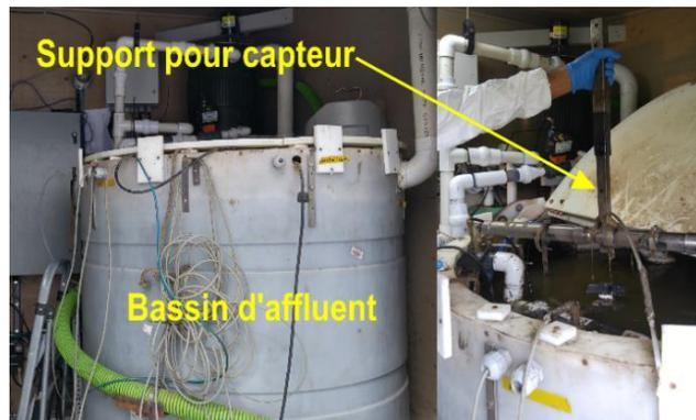
Figure 3.10 : Bassin d'affluent et supports pour capteurs en ligne
