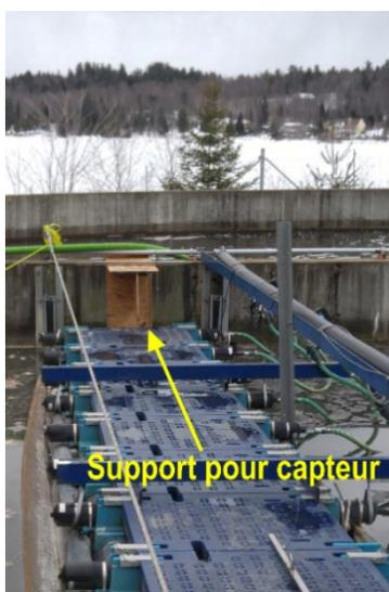
Figure 3.12 : Installation pour le suivi en continu des MES à la sortie des RX
