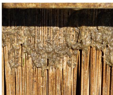
FIGURE I.3.14 – Filasses accumulées en haut d'un module de filtration, prises en photo au début d'un lavage de régénération
