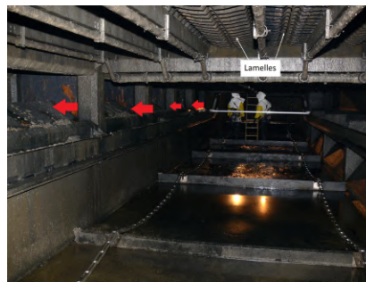
FIGURE 4.25 – Intérieur d'un décanteur primaire lamellaire. Les flèches rouges désignent les trappes d'alimentation du décanteur (courtoisie de Yves Lanthier).
