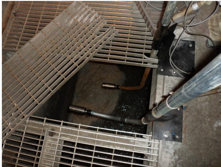
FIGURE E.1 – Installation de capteurs redondants.
