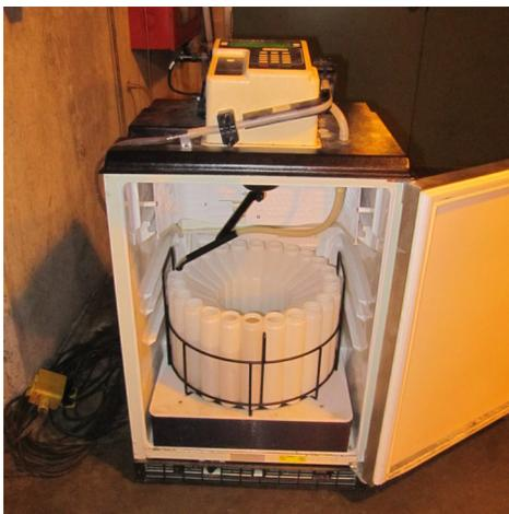
FIGURE 3.7 – Échantillonneur automatique réfrigéré de type SIGMA SD 900, installé à l'entrée des décanteurs primaires à la StaRRE Est de la Ville de Québec.
