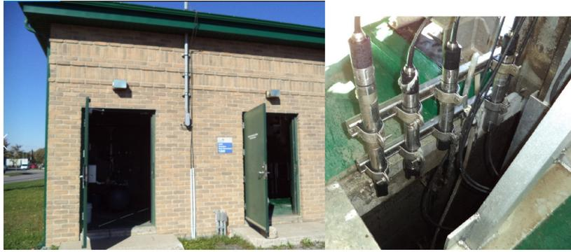
FIGURE 3.4 – Chambre de contrôle du BR de Saint-Sacrement (à gauche) et localisation où l'échantillonneur et les capteurs ont été installés (à droite).
