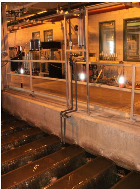
FIGURE 3.17 – Système d’injection du polymère, photographie d’un des cinq points d’injection situé à la sortie d’un dessableur.
