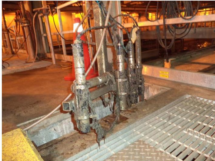
**Figure 5 : Photo des capteurs encrassés avant nettoyage**
