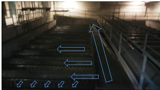
L'eau se sépare en deux après les vis et rejoint 2 grandes gouttières qui elles même répartissent le débit dans des gouttières plus petites depuis lesquelles l'eau s'écoule, se brise sur une barre métallique, avant de se répartir sur les biofiltres en contrebas.
