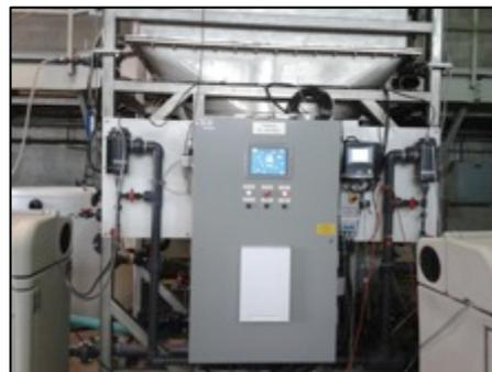
Figure 4 Pupitre de commande du pilote
