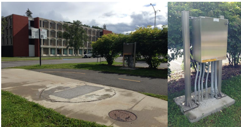
Figure 4. Résidence et station de pompage
