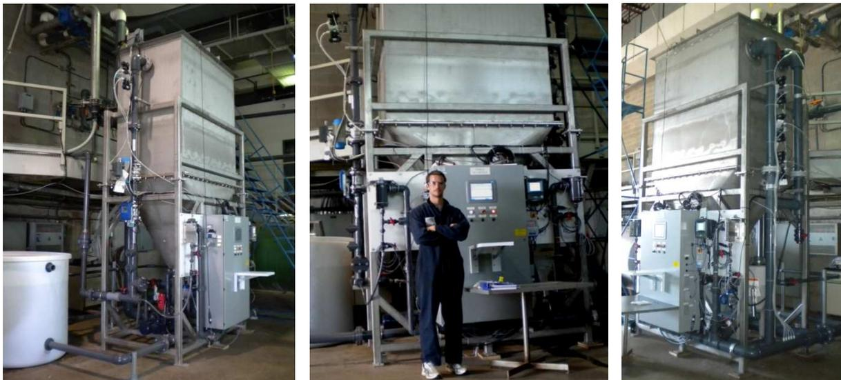
Figure 2 : Décanteur Pilote sous 3 vues à la station d'épuration Est de Québec
