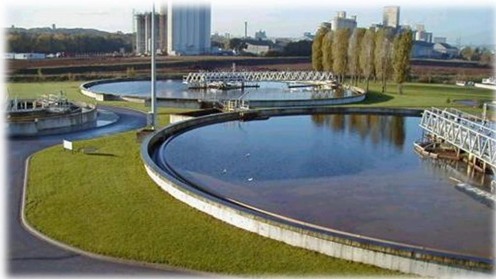
En sortie de réacteur biologique, l'eau va subir une clarification pour ensuite repartir en recirculation avec une partie de l'eau (propre et le plus dépolluée possible) rejetée en rivière ou dans le milieu naturel. En vue de maintenir une concentration constante en micro-organismes épurateurs, les boues doivent séjourner le moins possible dans le clarificateur.
