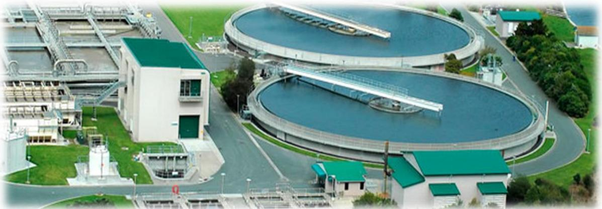
Suite à son passage dans les différents réacteurs biologiques, l'eau usée va subir un traitement secondaire, en vue d'éliminer les particules polluantes, ou néfastes pour l'environnement lors de son passage dans le décanteur secondaire. La décantation secondaire vise à la biomasse de l'eau traitée et permet ainsi une solidification et un début de formation des boues biologiques décantées.
